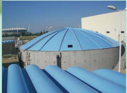
Ouvrage Epaisseur    Thickening Structure
